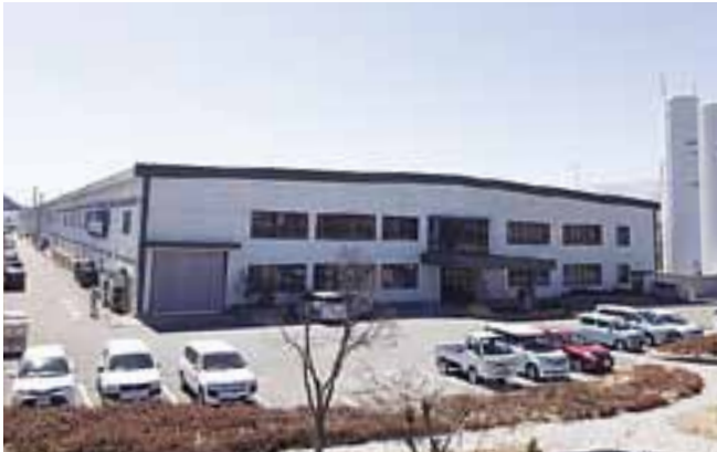
ニチコン製箔株式会社 大町工場
